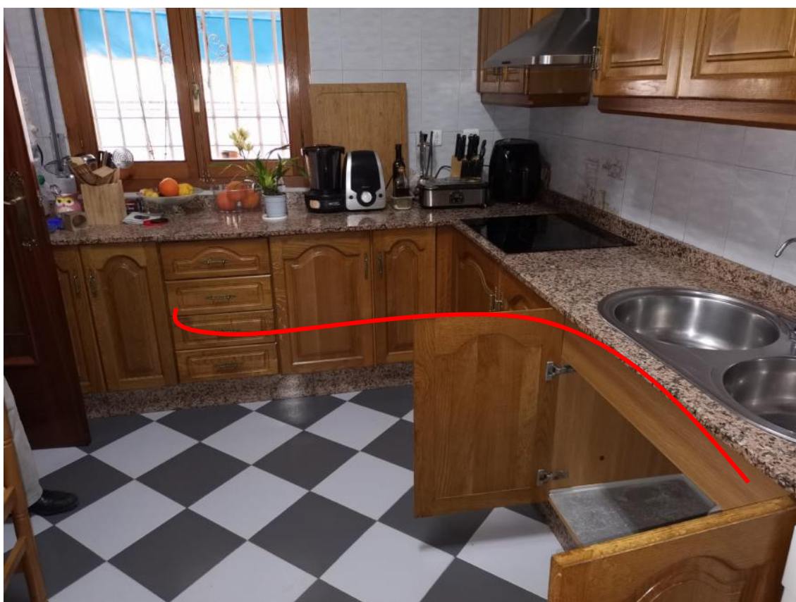
Recorrido del conducto hasta llegar al patio bajo la ventana.
