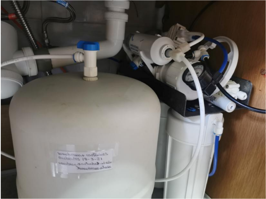
Equipo de osmosis una vez reparado. 18 marzo de 2.021
