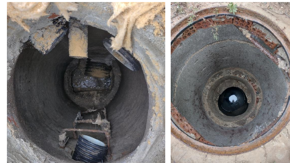
Pozo P1 con rasante a 3.8 m (izquierda) y pozo P2 con rasante a 4.8 m (derecha)
